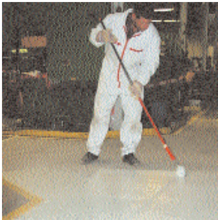
ASODUR®-D2 в качестве поверхностного слоя в складском помещении
