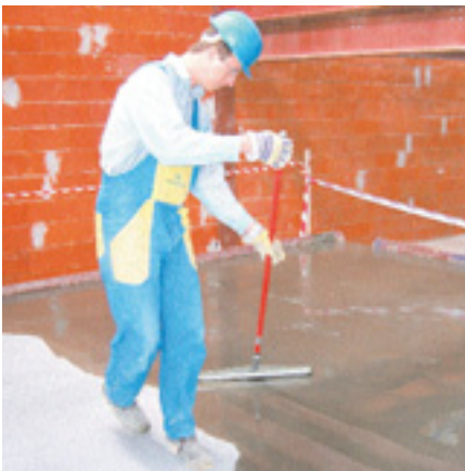
Нанесение ASODUR®-BI при помощи шибера из губчатой резины
